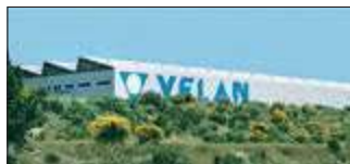
Lisbon, Portugal Velan Válvulas Industriais, Lda.
